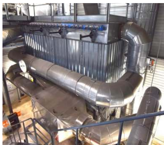
Le filtre à manches de la chaufferie de Saint-Affrique, photo FD
