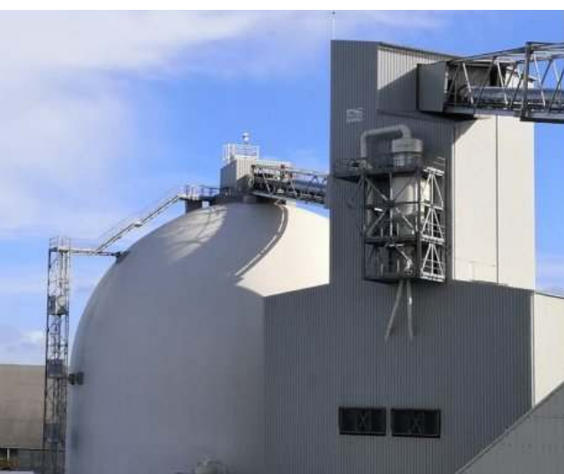
Poste d'aspiration de poussières de granulés de bois sur un terminal de stockage portuaire, photo Cattinair
