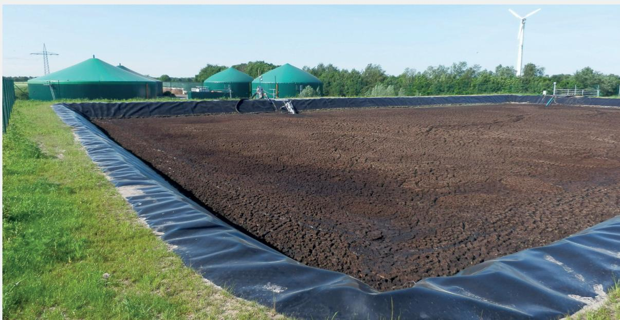
Réservoir de substrat de digestat 8 400 m<sup>3</sup>
