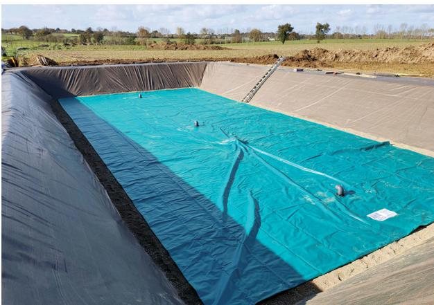
Réservoir d'engrais liquide avec bassin de récupération
