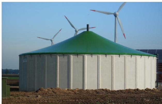
Toit pour biogaz sur réservoir en béton préfabriqué
