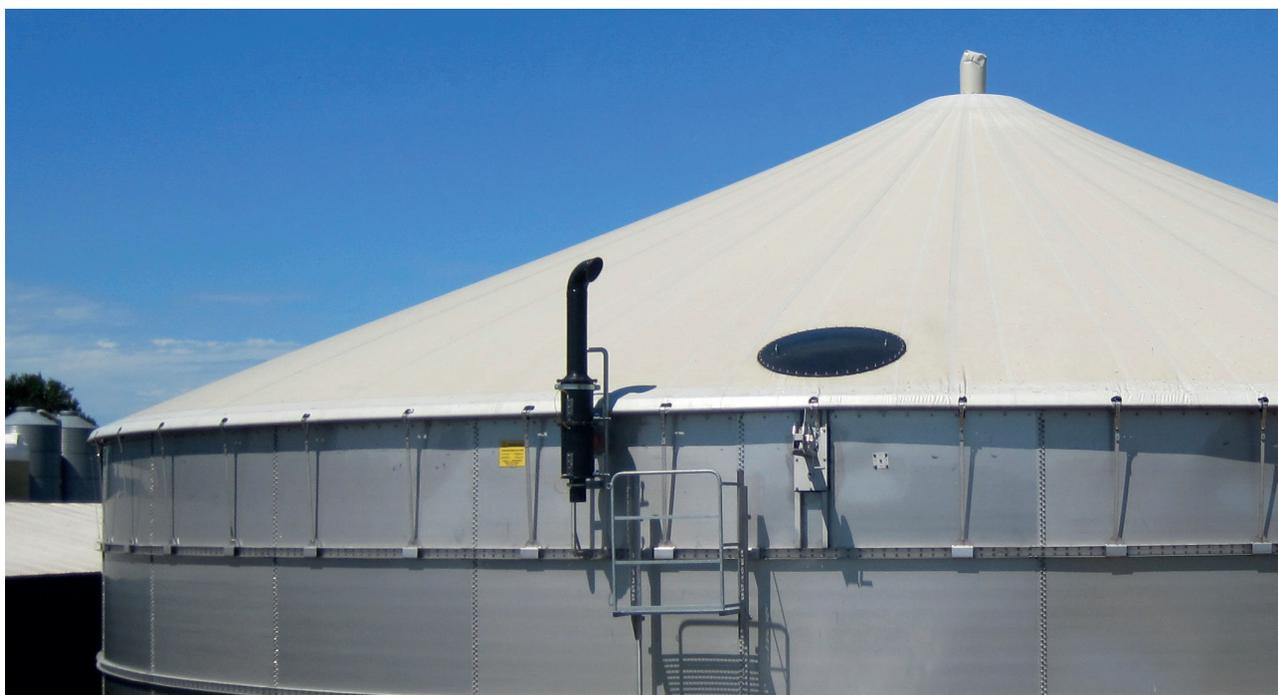
Toit pour biogaz sur réservoir en acier inoxydable
